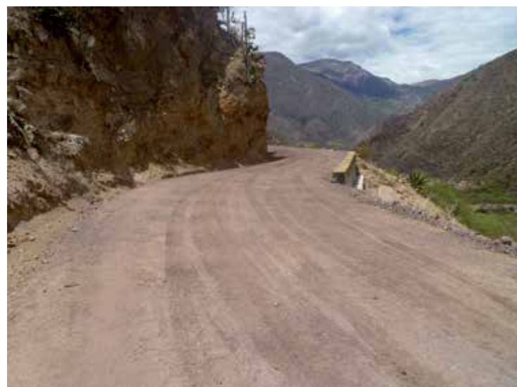
Municipalidad de Sarhua, Provincia Víctor Fajardo, Región Ayacucho: Camino antes y después de la intervención del FPA.
